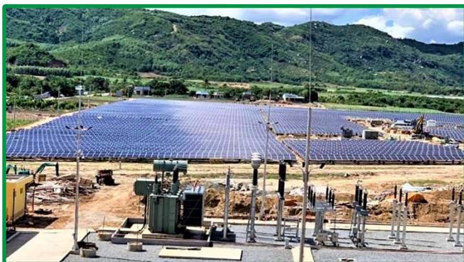
Phần mềm SCADA quản lý trạm 110kV nhà máy NLMT - EVNCPC
