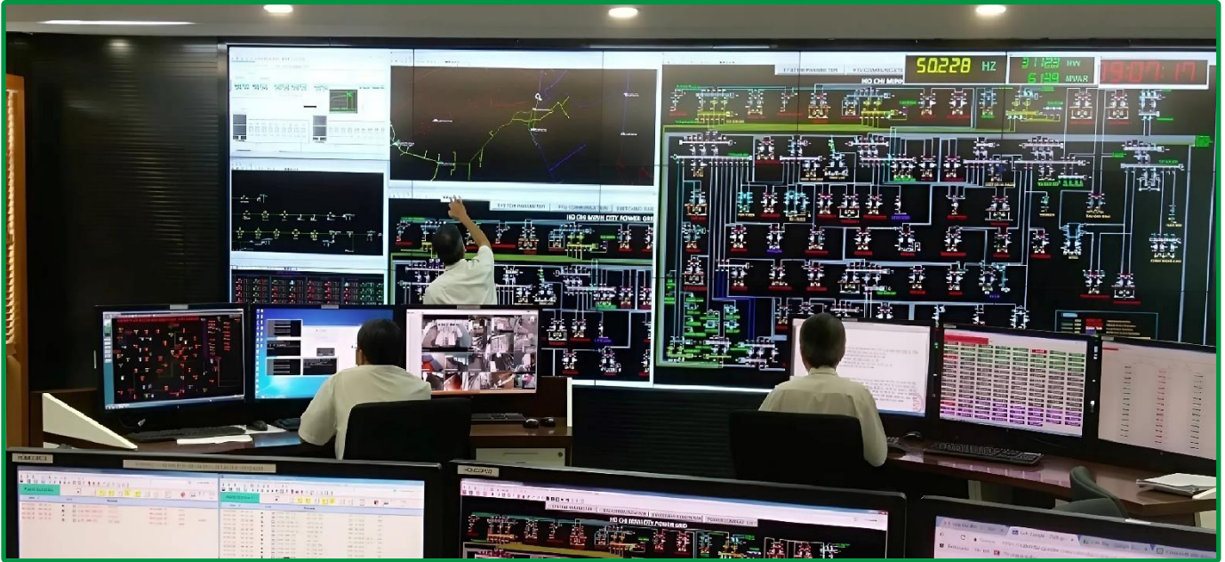
TTĐK Tổng Cty Điện lực TP.HCM (TT2) Vận hành tự động hoá trên 900 xuất tuyến chức năng FLISR
