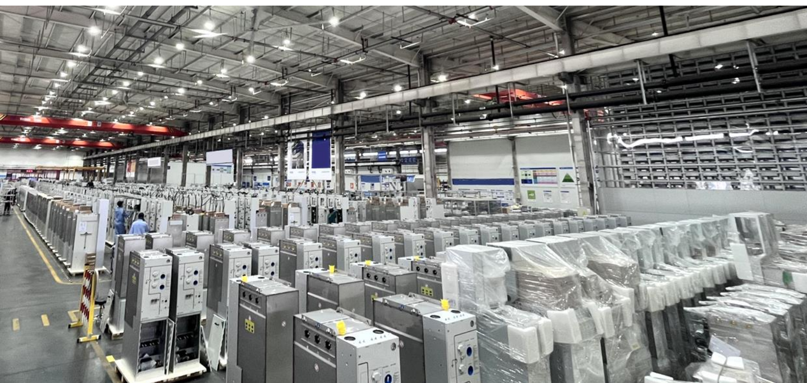
Nhà máy EATON sản xuất tủ trung thế RMU
